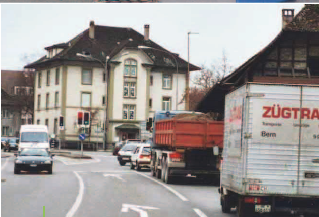
Zone 30 de Köniz : l'espace routier aujourd'hui (en haut) et avant le réaménagement (en bas).
