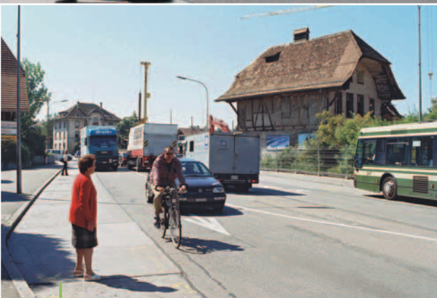
Zone 30 à Köniz : Blauäckerplatz avec le bâtiment historique de la Scherzhaus aujourd'hui (en haut) et avant le réaménagement (en bas).
